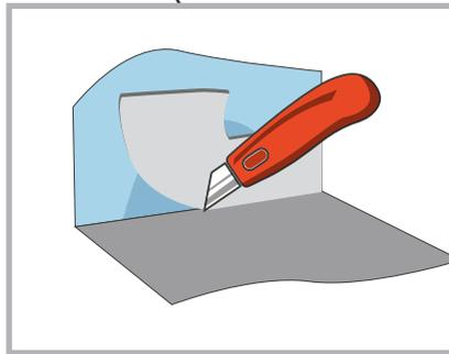
Обрезаем излишки ТермоЗвукоИзола и заполняем пространство вибро-акустическим герметиком Сонетик
